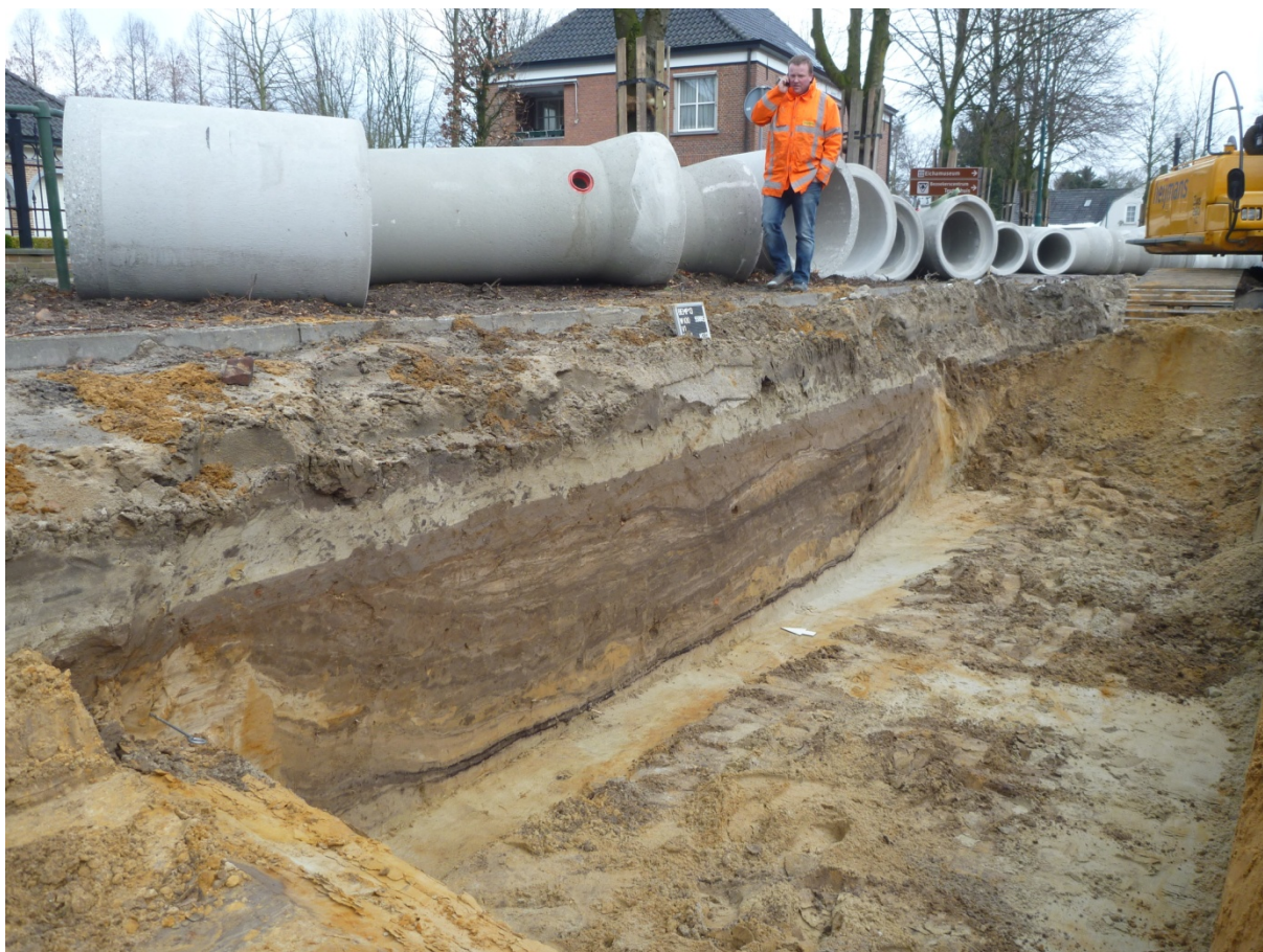
Fig. 4 S1041. Één van de twee mogelijke drenkkuilen in werkput 100.
