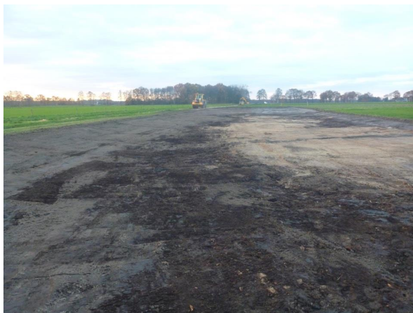
Figuur 6. Bezandingspakket op veen op Sterksel bij plasdraszone 3.
