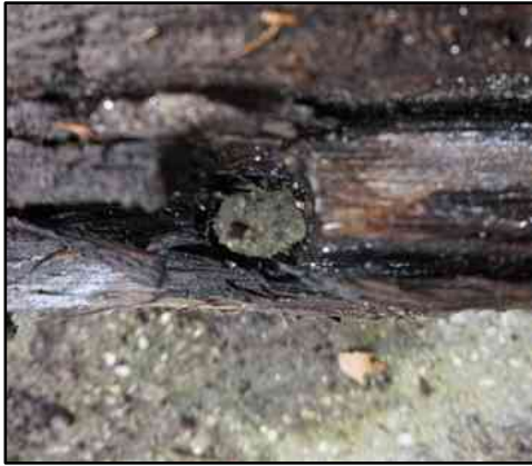
Figuur 3. Detailopname van het gat in schachtdeel dat haaks op de schacht is geboord (mogelijk met een avegaar).
