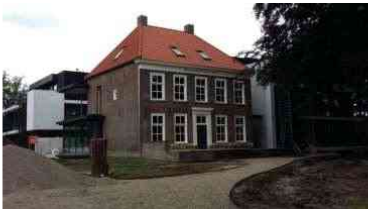
foto Bouwbedrijf Baken (website): (ver)bouwactiviteiten bijna afgerond
