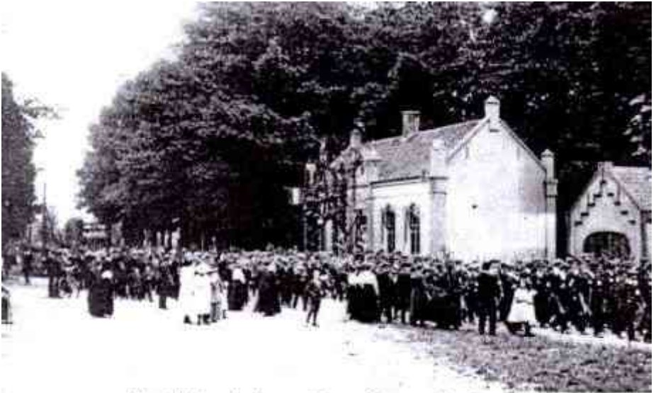
Het 1 e Raadhuis van Bergeijk aan “de Straat” met rechts zichtbaar het brandweehuisje.
