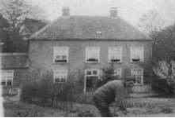
De achtergevel, nog zonder pleisterwerk.
