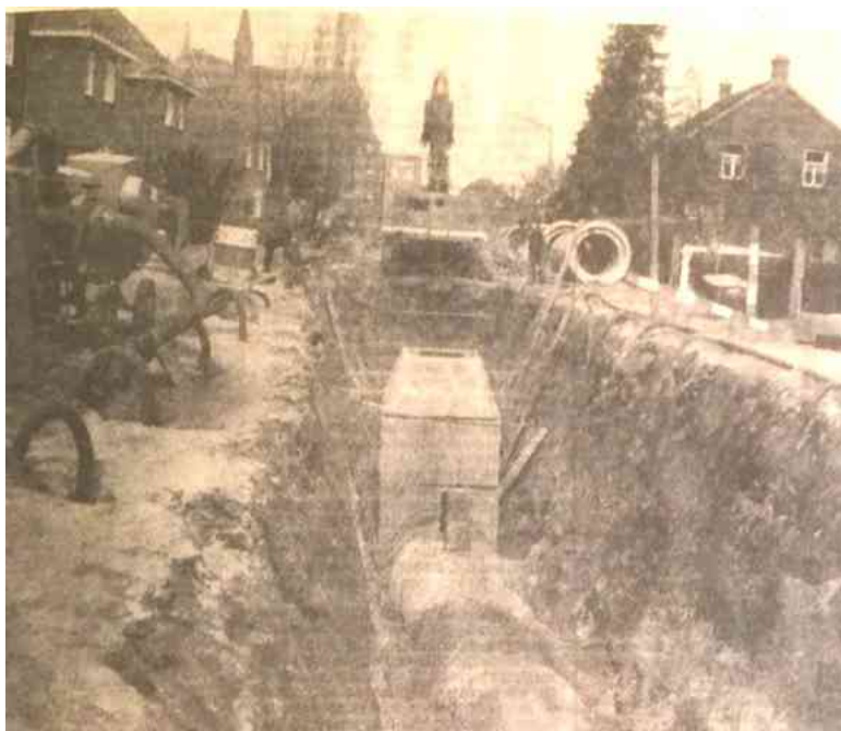
De aanleg van het riool in de Dokter Rauppstraat.
