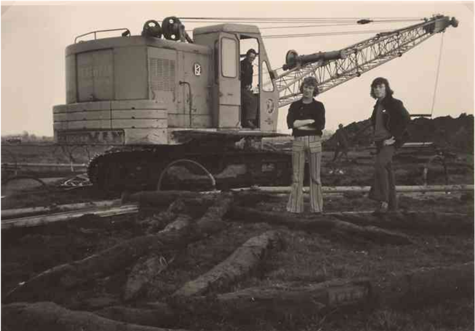
De dragline met enkele belangstellenden staan tussen een aantal palen (foto Johan Biemans)
